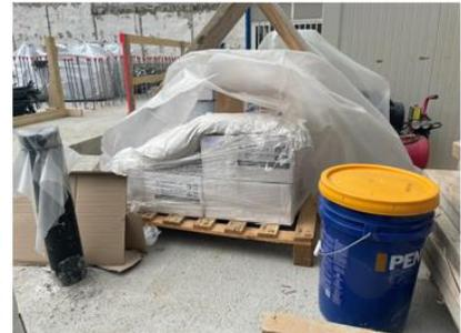
Il materiale stoccato nelle apposite aree di cantiere viene mantenuto sollevato da terra, su superfici impermeabili, e coperto con plastica per imballaggio. I materiali depositati in cantiere sono coperti e/o dotati di un proprio sistema di packaging per evitare contaminazioni con il percolamento delle acque meteoriche sul suolo.
